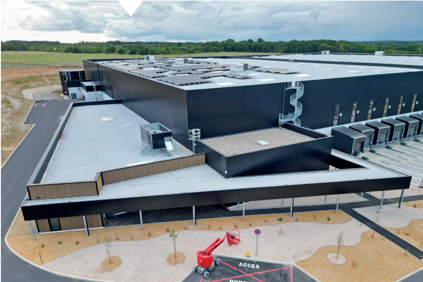
Vue aérienne d'AUTONOM® en cours de construction
