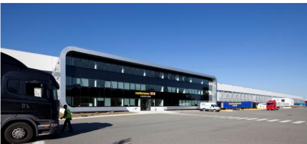
14) Châtres (alongside route nationale 4, 77)
