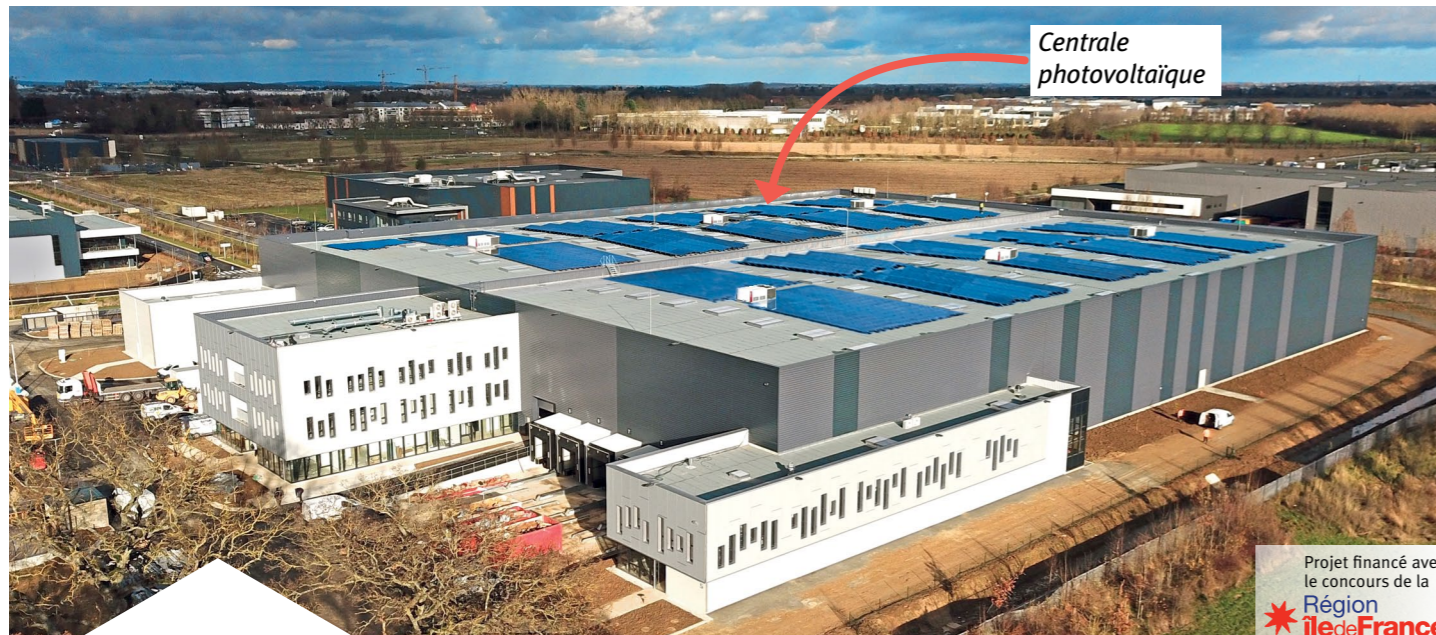
Vue aérienne d'AUTONOM® en cours de construction
