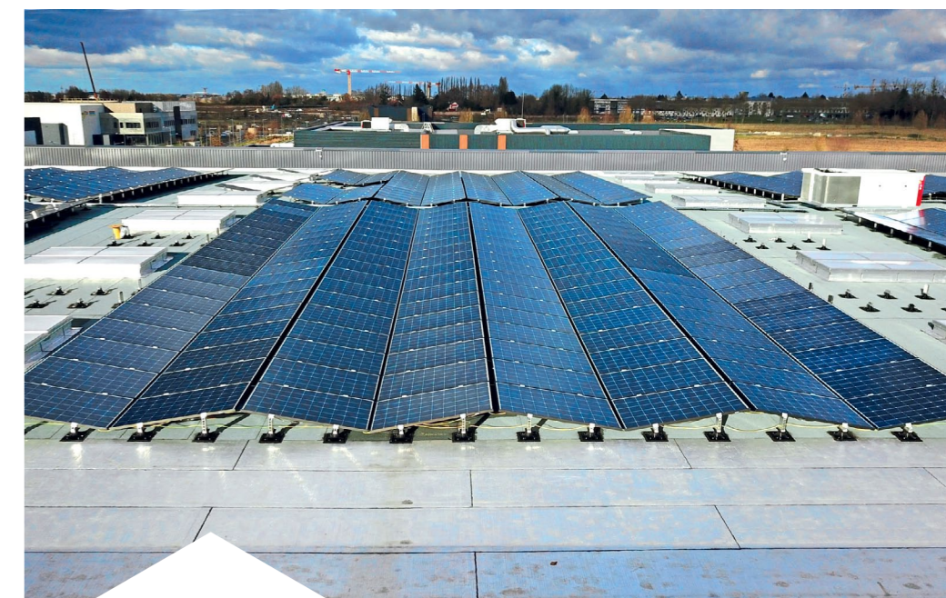
Toiture d'AUTONOM® avec panneaux photovoltaïques
