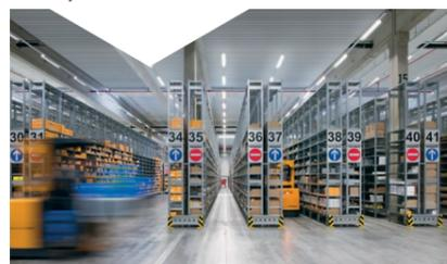
On évite ainsi qu'ils restent allumés lorsqu'il fait clair naturellement, ou pendant les périodes où l'entrepôt est peu fréquenté. Un tel système permet de **diviser par 8 la consommation d'électricité et les émissions de CO<sub>2</sub>** par rapport à un système d'éclairage traditionnel à iode métallique.
