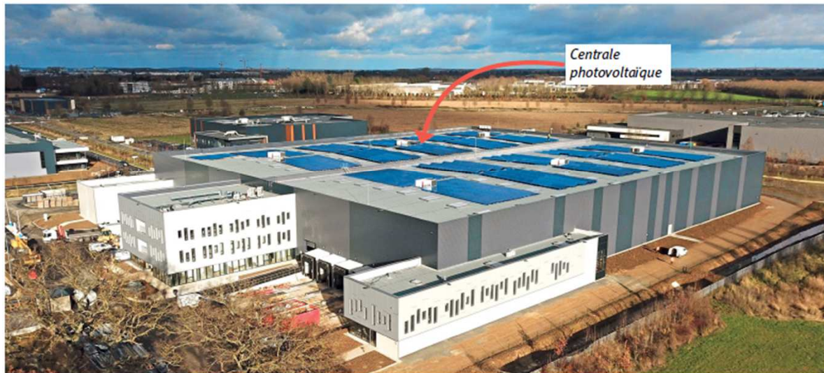
Vue aérienne d'AUTONOM® en cours de construction
