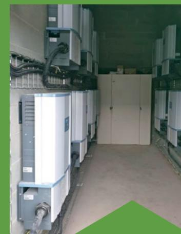
**Les onduleurs** transforment le courant continu en courant alternatif 380V compatible avec les installations de l'exploitant.
