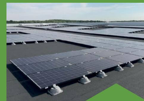
**Les panneaux photovoltaïques** disposés en toiture produisent de l'électricité de type courant continu.
