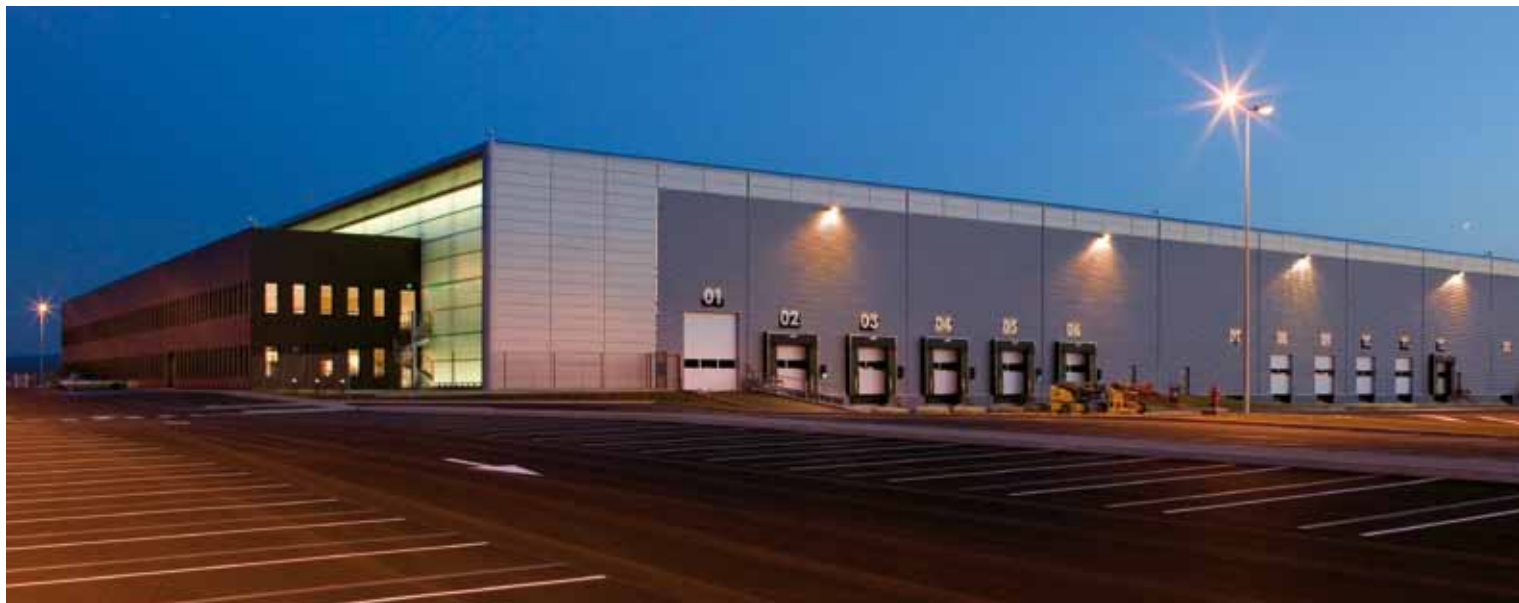
Vue d'ensemble angle bureaux / façades quais
