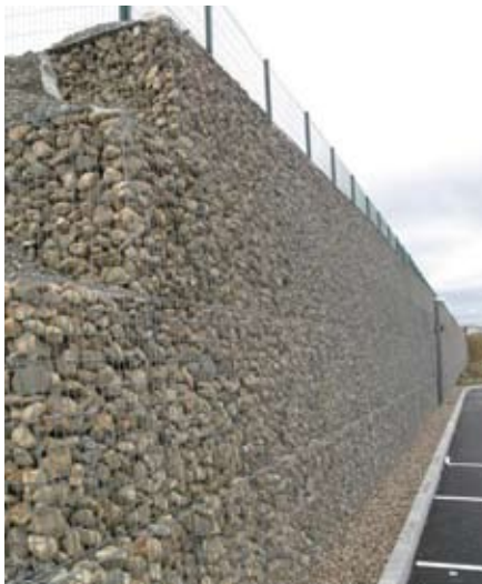
Mur gabion, réalisé à l'aide de véritables galets de l'Allier.
