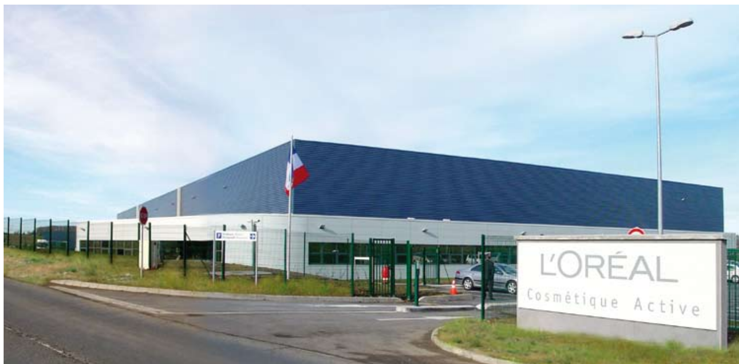
Photo: ARGAN - Architectes : A.I.L.L.P./Françoise Parlange, Architecte DPLG
