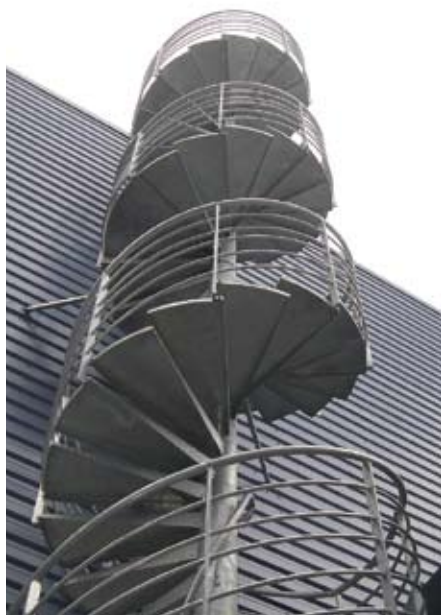
Escalier d'accès sécurisé à la toiture
